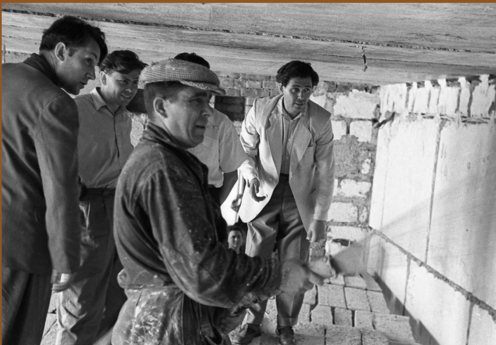
Герой Социалистического Труда Н.А. Музыка, бригадир штукатуров СУ-42 треста «Севастопольстрой», за демонстрацией одного из передовых методов штукатурных работ (с помощью распылителя) 1963 г. Фото А. Баженова
